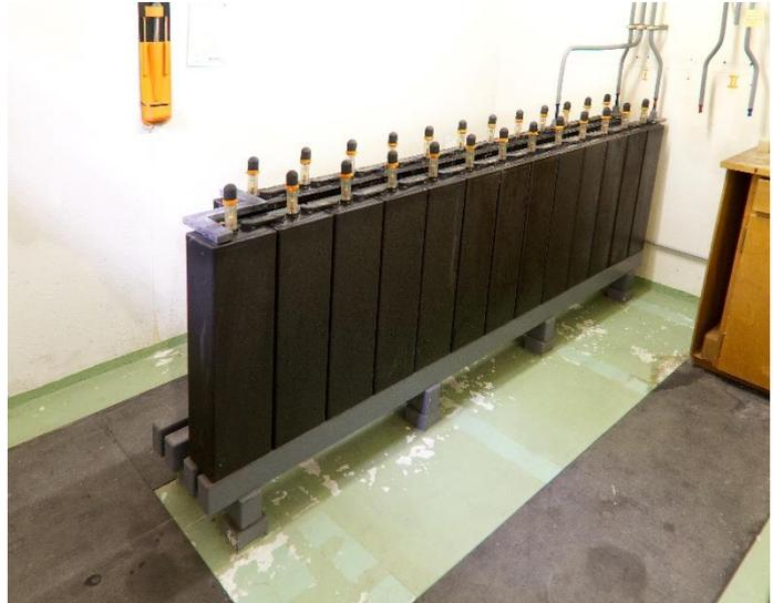
Bild 16 Bleiakkumulatoren in der Zentrale Magden. Sie liefern im Betrieb einen stabilen Gleichstrom und sorgen bei Stromausfall für einen Notbetrieb. (Museum für Kommunikation)
