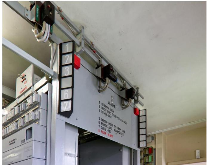
Bild 50 Alarmtafel an der Front der Automatengestelle. Störungen mussten rasch gefunden und behoben werden können, weshalb die Anlage mit einer entsprechenden Diagnoseeinrichtung ausgerüstet ist. Ein weiterer wichtiger Bestandteil der zuverlässigen Störungsbehebung war die Betreuung der Anlage durch erfahrene und kompetente Techniker. (Museum für Kommunikation)
