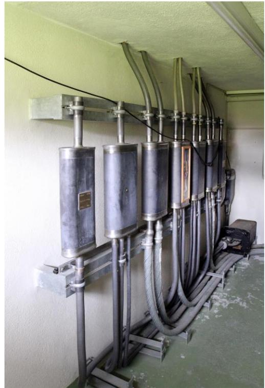
Bild 36 Im Keller befindet sich die Einführung der Telefonkabel aus dem Einzugsgebiet der Zentrale sowie der hier ersichtlichen Bezirkskabel. (Museum für Kommunikation)
