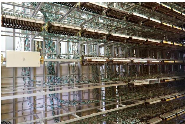
Bild 57 Am Hauptverteiler werden die Kabel an die Zentrale angeschlossen. Pro Kunde sind zwei Adern notwendig. Anhand dieser Anschlüsse ergab sich im vordigitalen Zeitalter die Telefonnummer. (Museum für Kommunikation)
