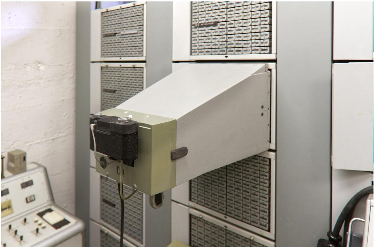
Bild 21 Gebührenzähler in der Zentrale Magden. In jeweils rechteckigen, standardisierten Segmenten sind Gebührenzähler angeordnet. Für die Rechnungsstellung Ende Monat wurden die Zähler manuell mit einer Fotokamera fotografiert und anschliessend ausgewertet. (Museum für Kommunikation)
