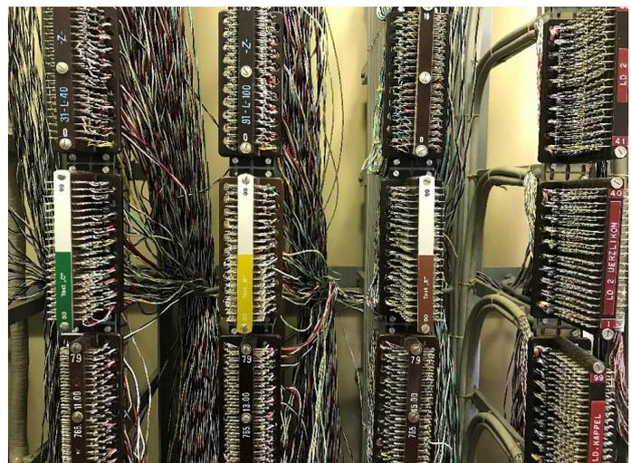
Bild 46 Anschlussbrücken am Hauptverteiler. Hier ist jedes Kabel der Abonnenten an die Zentrale angeschlossen. (Museum für Kommunikation)
