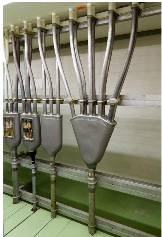
Bild 55 Die unterirdisch eingeführten Bezirkskabel mit entsprechend stark dimensionierten Kabelmänneln werden in sogenannten Bleimuffen aufgetrennt und in kleinere Einheiten aufgeteilt. Von hier aus werden die Kabel auf den Hauptverteiler im Erdgeschoss geführt. (Museum für Kommunikation)
