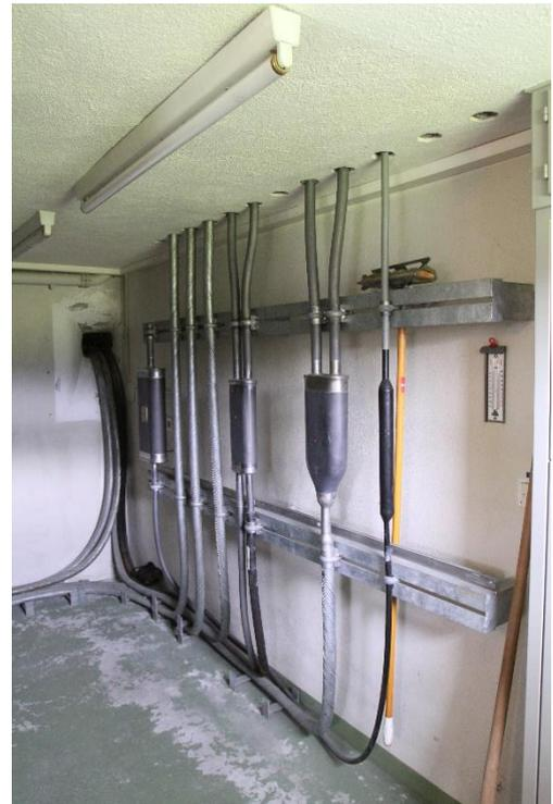
Bild 15 Kabeleinführung und Verteilung im Keller der Zentrale Versam. (Museum für Kommunikation)
