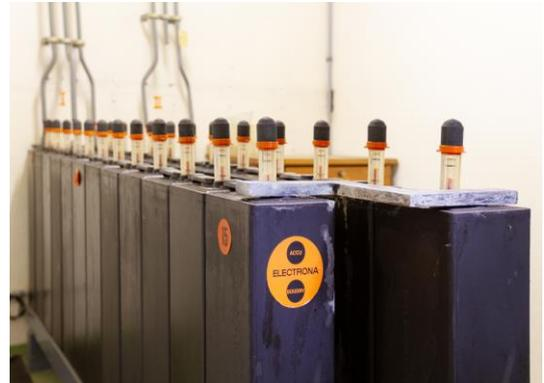
Bild 54 Batterieraum im Keller der Zentrale. Zeitweise waren zwei der abgebildeten Einheiten in betrieb und stellten bei Stromausfall einen autonomen betrieb der Zentrale sicher. (Museum für Kommunikation)
