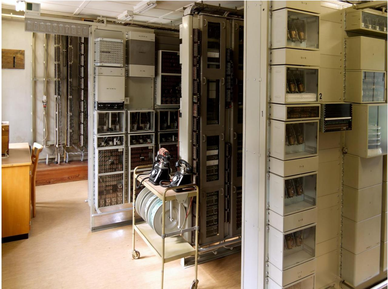
Bild 37 Der Automatenraum im alten Gebäudeteil. Im Hintergrund ist der Hauptverteiler platziert, wo die einzelnen Abonnenten angeschlossen sind. In den Gestellen im Vordergrund sind die Automaten-einrichtungen montiert. (Museum für Kommunikation)
