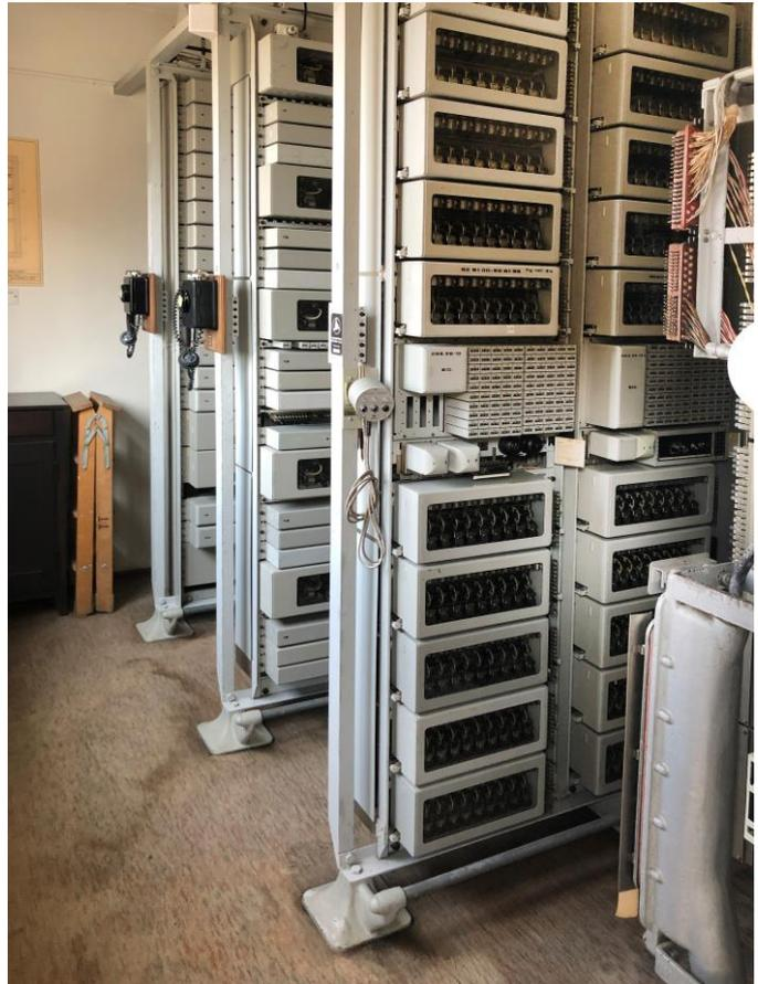
Bild 31 Der Automatenraum der Telefonzentrale Frieswil. Quer zum Fenster sind die Gestellreihen angeordnet. Durch den modularen Aufbau konnte ein grosser Teil der aufwändigen Montagearbeiten bei der Herstellung in den Fabrikhallen von Siemens Albis vormontiert werden. (Museum für Kommunikation)
