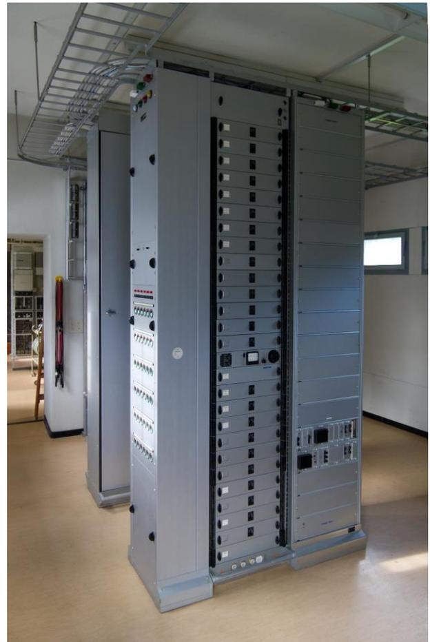
Bild 42 Im ersten Raum befinden sich Verstärkereinrichtungen für Transitleitungen. Diese Kabel sind nicht an die Zentrale angeschlossen, sondern werden von der Hauptzentrale Chur weitergeführt nach Illanz. In der Zentrale Versam werden lediglich die Signale verstärkt. (Museum für Kommunikation)
